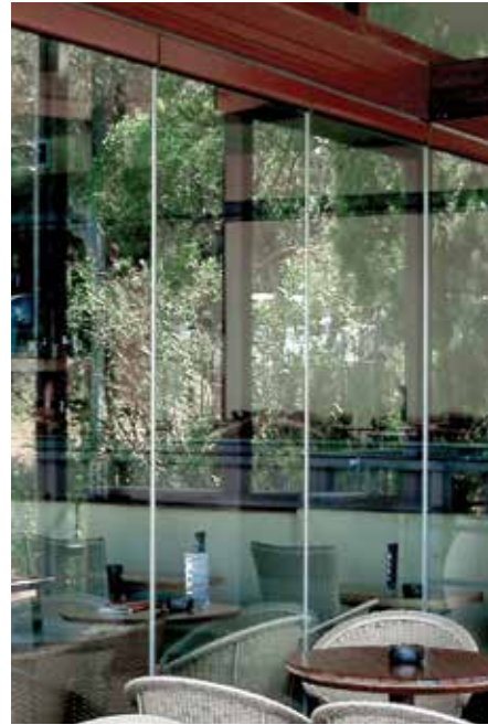
ΣΤΕΓΑΝΟΠΟΙΗΣΗ ΑΝΑΜΕΣΑ ΣΤΑ ΓΥΑΛΙΑ ΜΕ ΠΟΛΥΚΑΡΒΟΝΙΚΟ Η PVC ΣΕ ΟΛΟ ΤΟ ΜΗΚΟΣ ΤΟΥ ΦΥΛΛΟΥ
